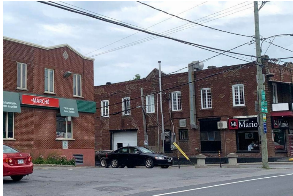
Protection intégrale du bâtiment
