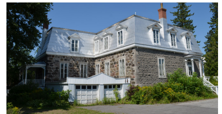
Variante avec plan en L et toiture avec terrassons et brisis sur chaque façade.
