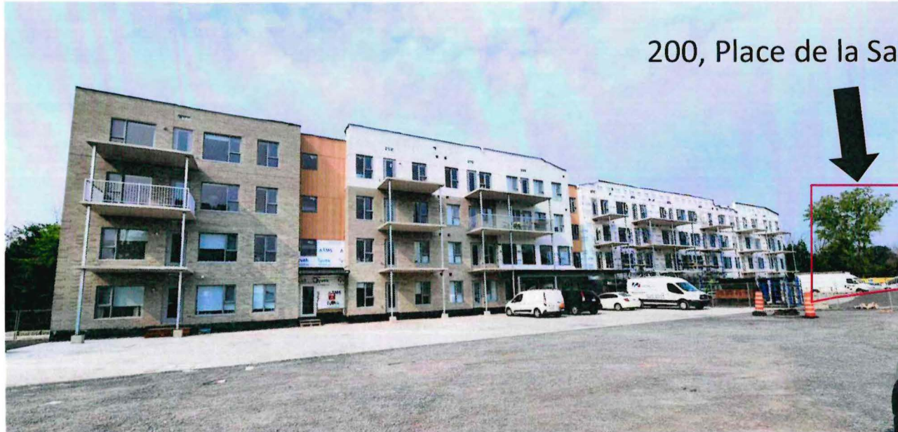
100, Place de la Saint-Jacques Travaux en cours
